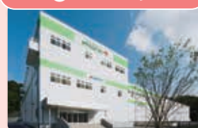
▲ユーコープ商品検査センター
