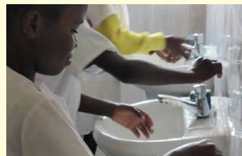
ユニセフの支援で設置された衛生施設で手を洗う子どもたち(クイト市エベン・エゼール小学校)
